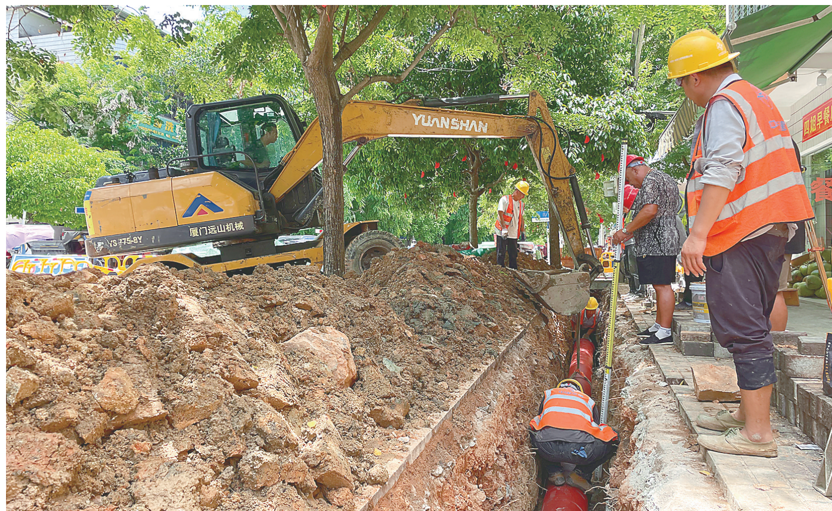
在那大镇德义路,工人正在埋设雨污管道。 儋州市融媒体中心记者牛伟 摄
