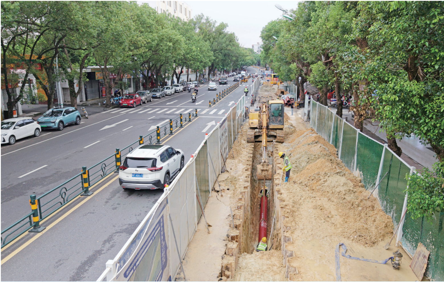
▲儋州市那大城区雨污分流改造及截流并网工程人民中段改造现场。 儋州融媒全媒体记者 羊文彪 摄
