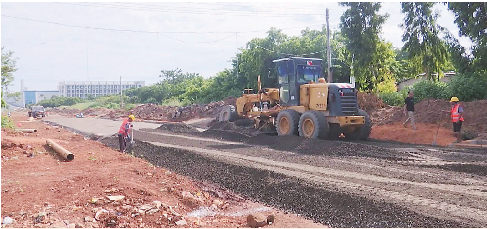
▲洋浦石化新材料产业园(二期)市政道路及配套工程(二阶段)施工现场。 洋浦政务 发
