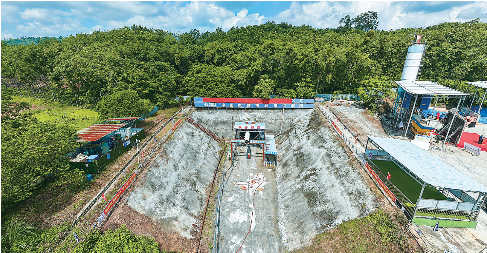
▲贯通隧洞入口。 儋州融媒全媒体记者 羊文彪 摄
