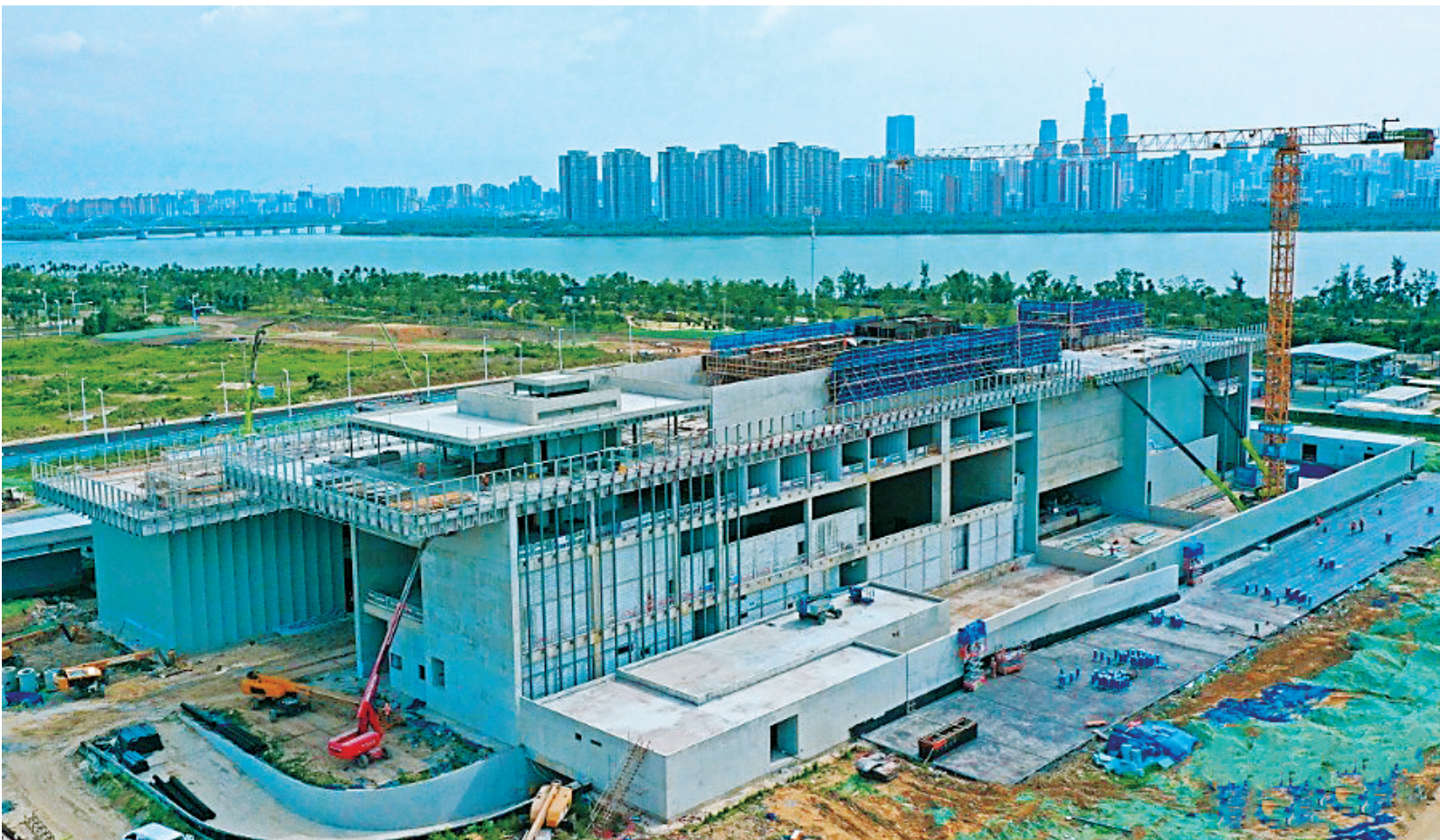
▲海南省首座大型美术馆项目建设现场,工程有序推进中。 南海网 发
