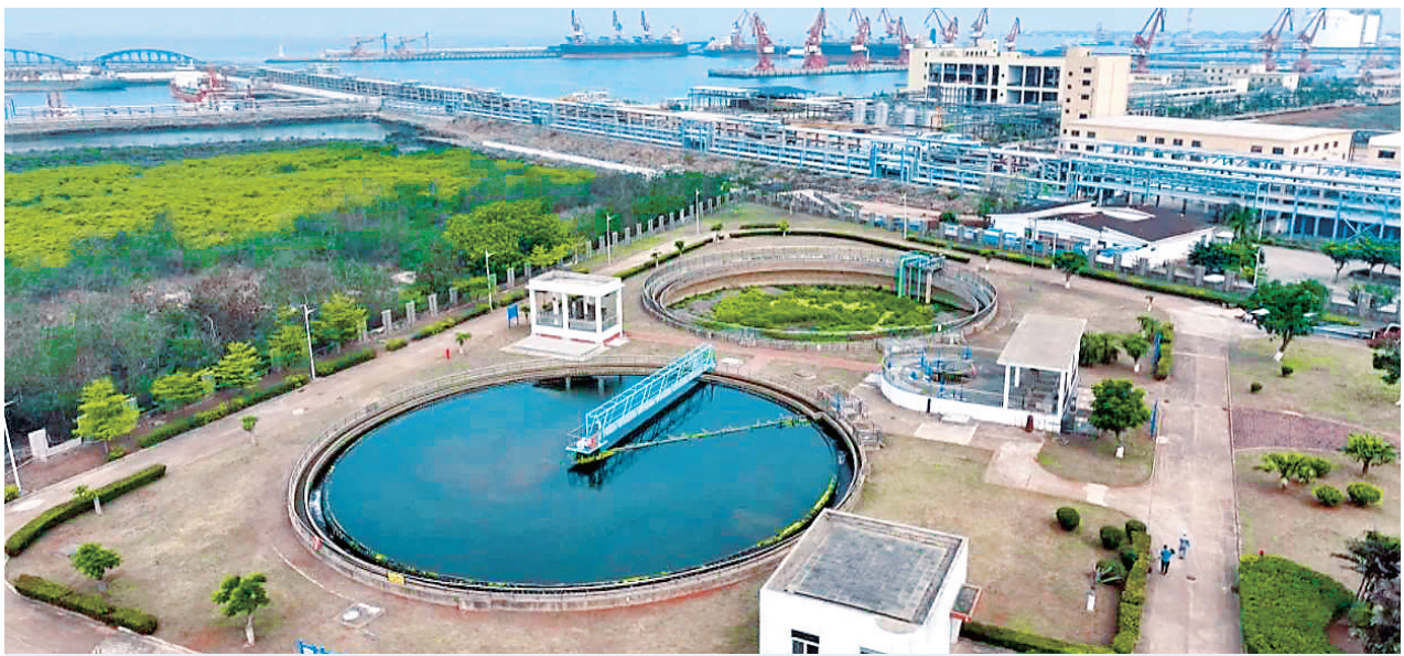
▲洋浦污水处理厂稳步推进升级改造与扩建工程。 洋浦政务 发
