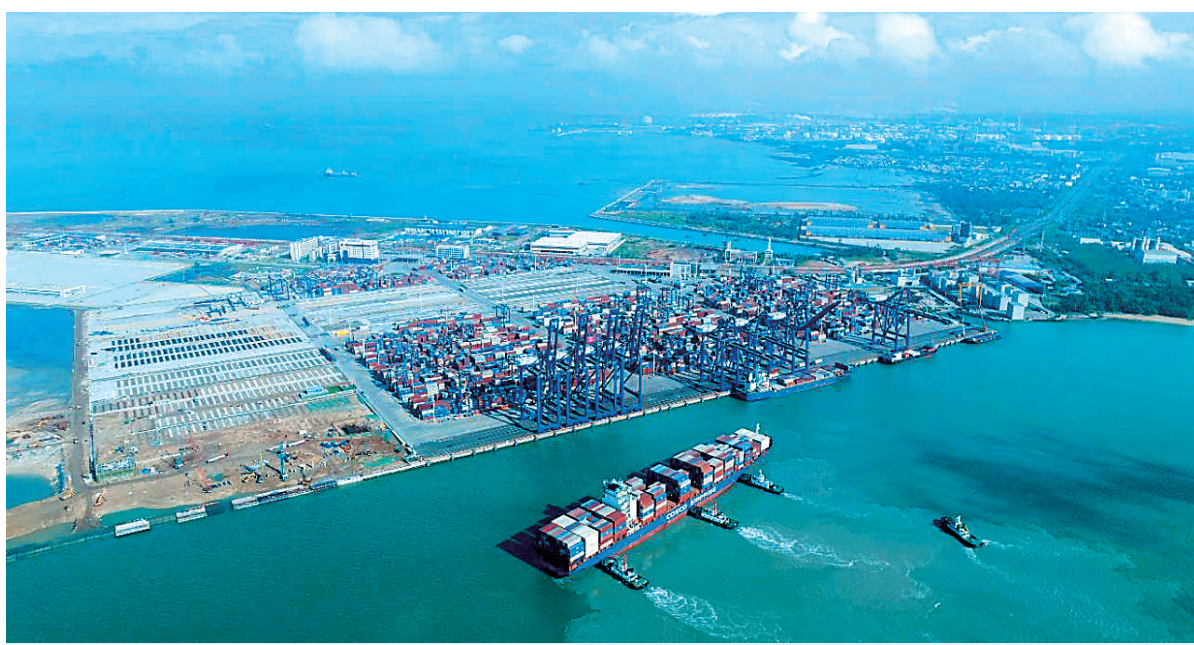
▲航拍海南洋浦国际集装箱港扩建工程建设现场。
