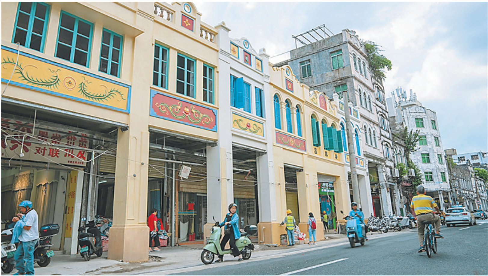
匠心传承 修缮古建 8月21日,在海口骑楼历史文化街区博爱路保护修缮项目施工现场,修缮后的建筑令人眼前一亮。目前,该项目示范段工程已经处于收尾阶段。据了解,该项目涉及建筑254栋,完工后,有助于提升该区域旅游接待能力。 海南日报 发
