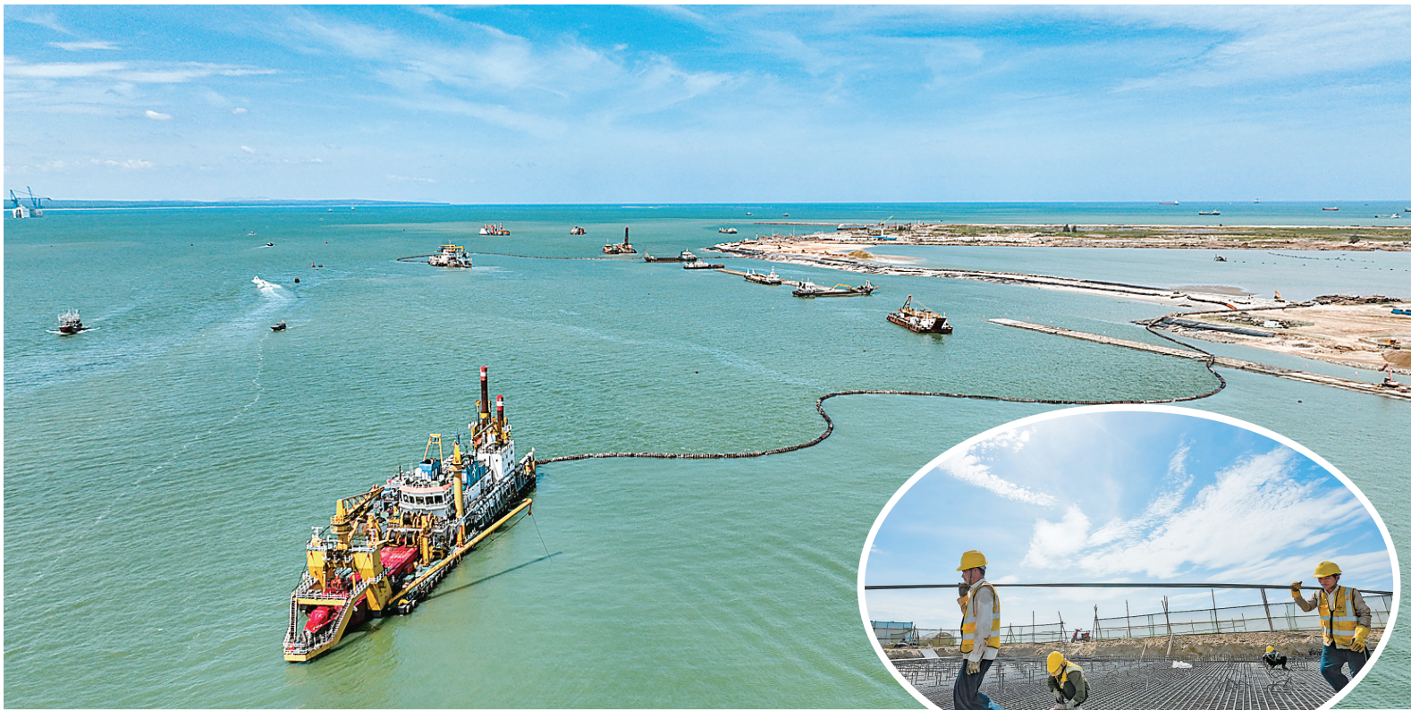
8月19日,洋浦区域国际集装箱枢纽港扩建工程项目进入施工高峰阶段,施工方正全力推进码头岸线沉箱施工等工程。
