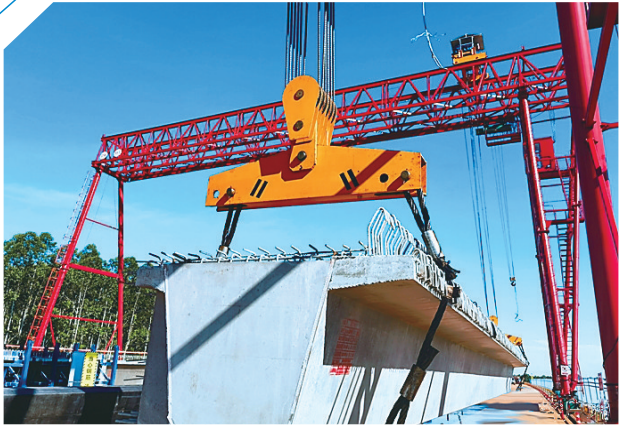
▲开始架设预制梁。 本组图片由南海网 发
