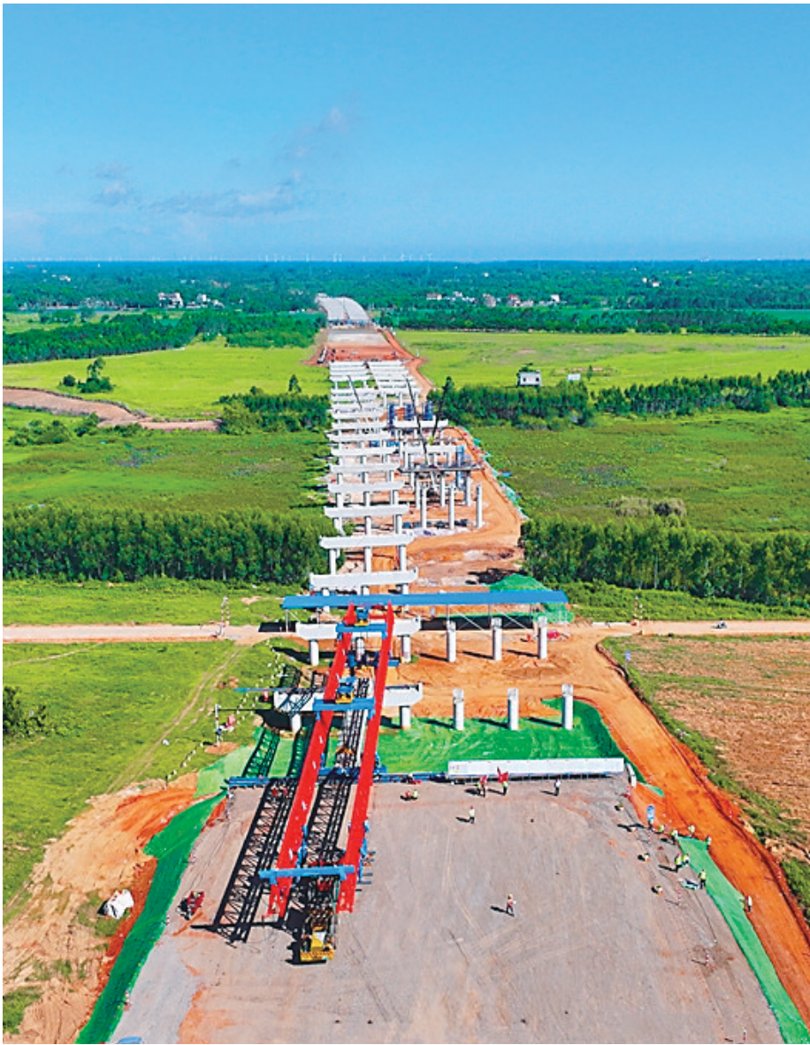
▲洋浦疏港高速公路SG01标项目施工现场。
