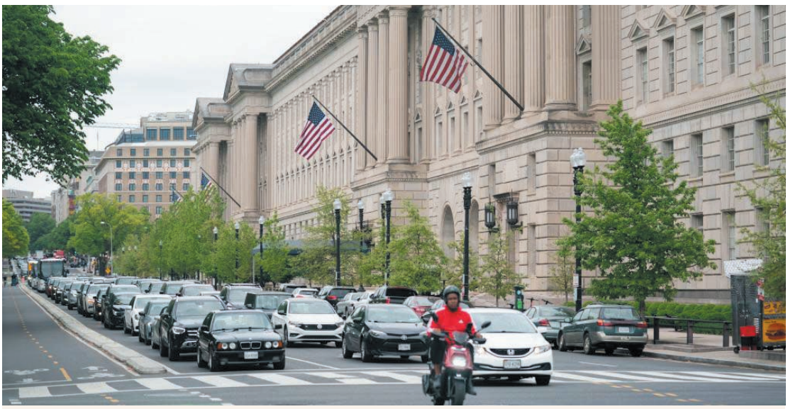
▲这是在美国首都华盛顿拍摄的商务部大楼。 新华网 发
