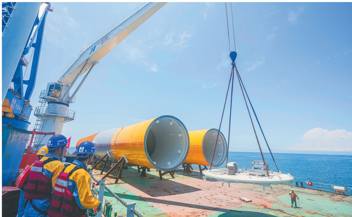
近日,在位于儋州北面海域的申能海南CZ2海上风电示范项目现场,工作人员正有序开展风机钢管桩沉桩工作,为海上风电装机提供固定式基础支撑。 海南日报记者陈元才 通讯员王小军 摄
