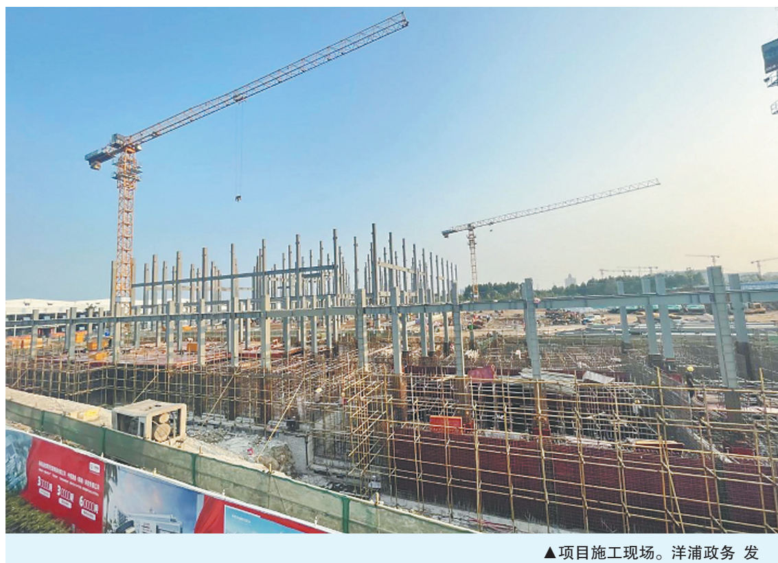
▲项目施工现场。洋浦政务 发
