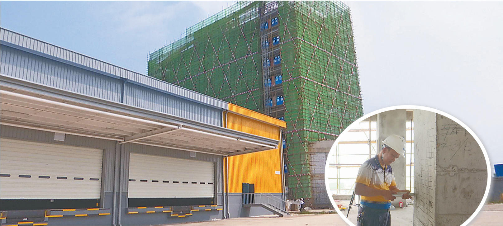
▲洋浦国际智慧供应链中心(一期)项目建设现场。
