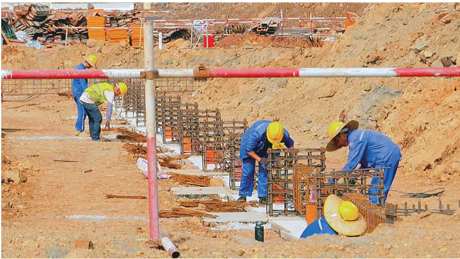
▲年产2万吨电池级氢氧化锂项目施工现场。 洋浦政务 发
