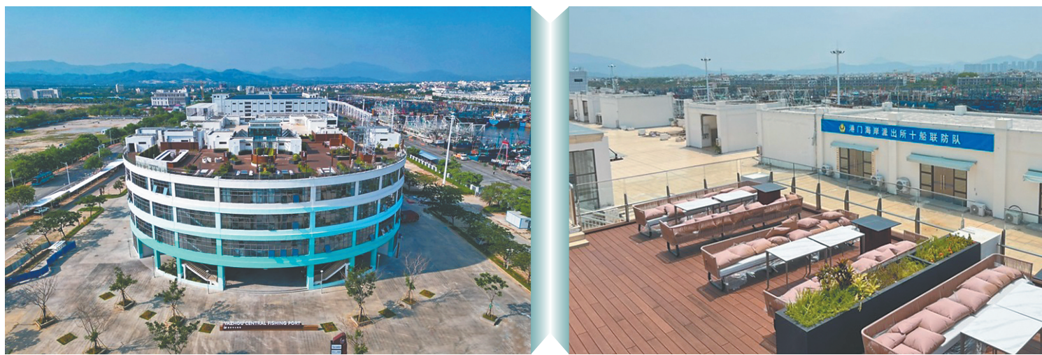
▲崖州中心渔港水产品交易中心改造项目航拍图。
