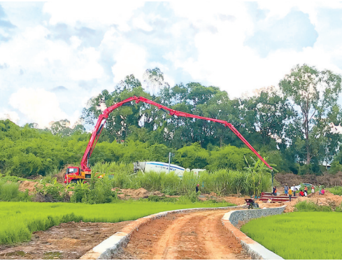
▲新州镇黄村村委会黄坡村至那甲村路段施工现场。儋州融媒全媒体记者 韦斌 摄
