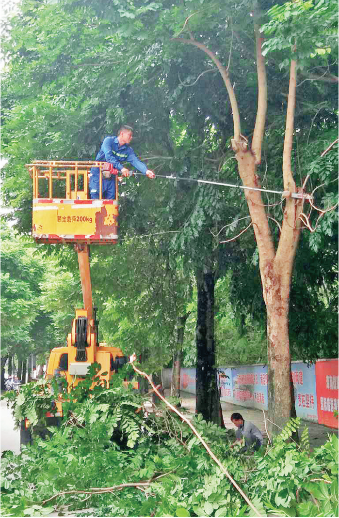
图为园林局工人修剪各路段行道树枝。本报见习记者 羊文彪 摄
